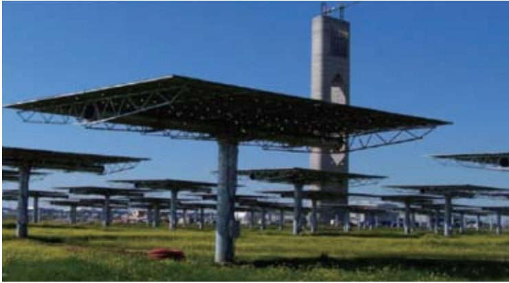
الشكل (٢) نظام البرج المركزي
