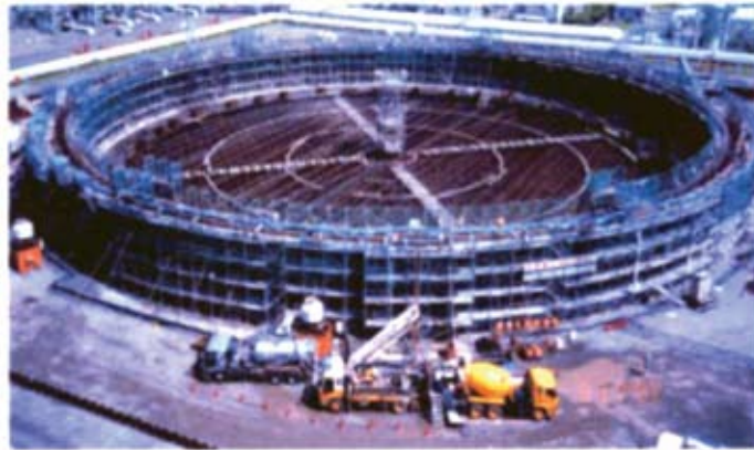
Fig. (12) LNG Tank, Osaka Gas Company, Japan
